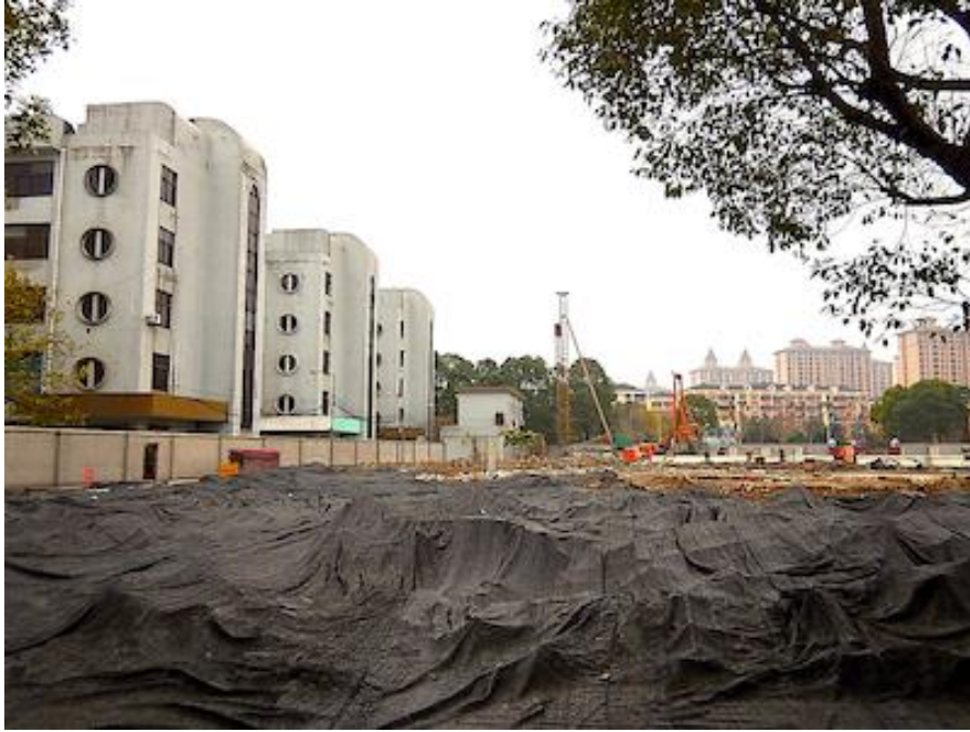
第一期工事中の建設現場
